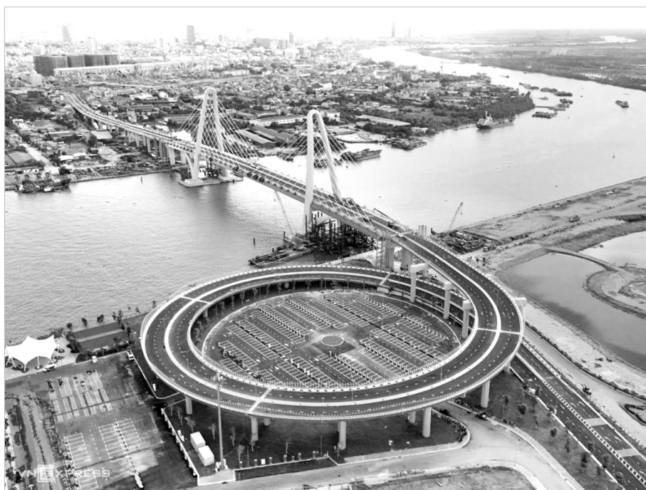
Toàn cảnh cầu Hoàng Gia kết nối đảo Vũ Yên với trung tâm thành phố
